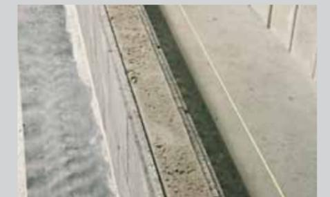
4. Après enlèvement des réglettes, le lit de mortier est parfaitement dosé et plan
