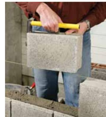
L'énergie dépensée par le maçon se répartit principalement entre la gestion du mortier (70%) et la préhension et mise en place du bloc (30%).
