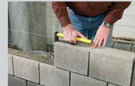
5. Manipulation et dépose du bloc à l'aide de la poignée-massette
