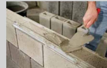
1. Dépose du mortier entre les réglettes de dosage
